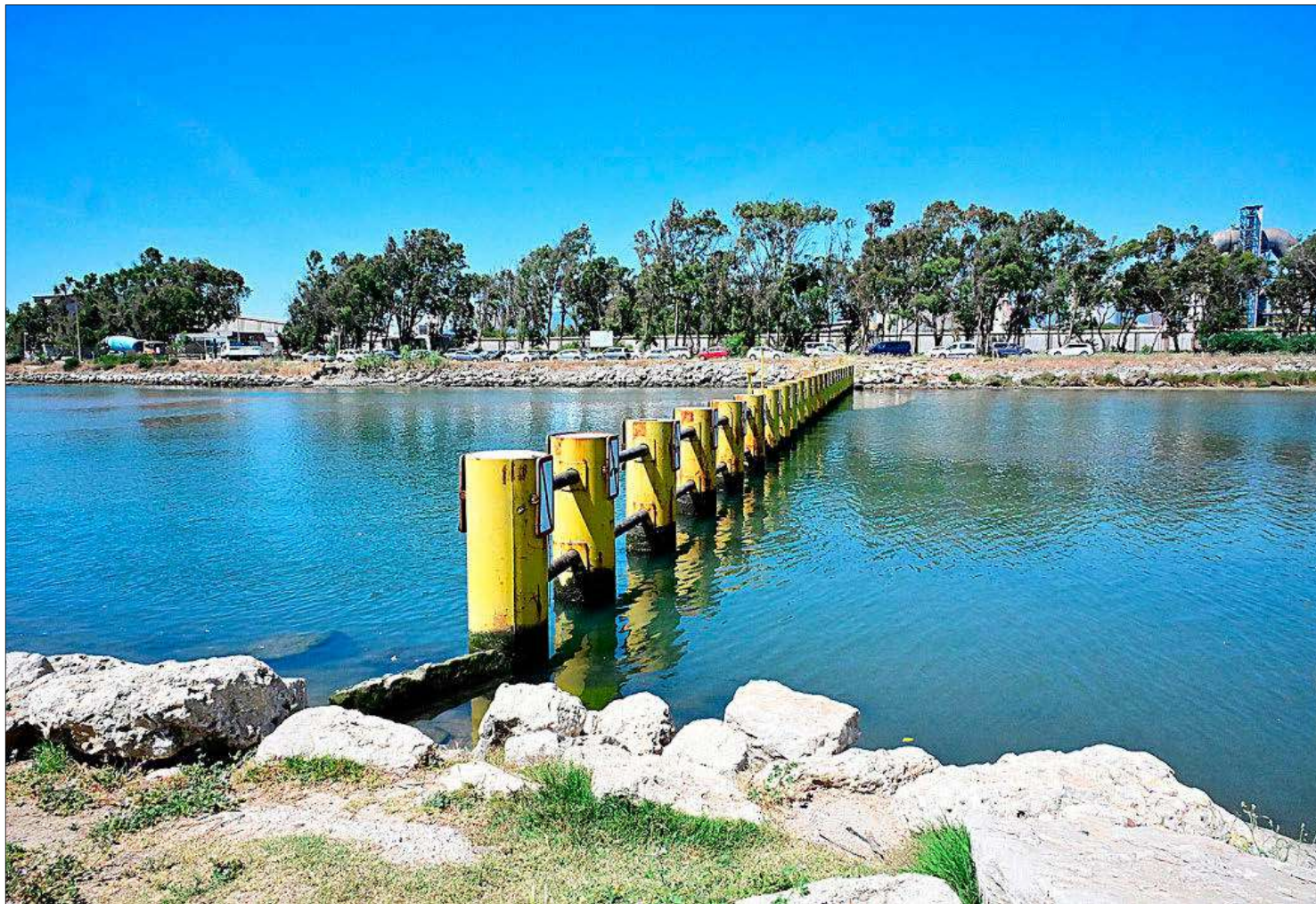
Barrera de pilotes de hormigón y acero contra el narcotráfico instalada en el río Guadarranque, en Cádiz, hace unos años. CATA ZAMBRANO
